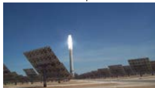
Figura 2. Torre Solar Gemasolar Sevilla 20Mw
